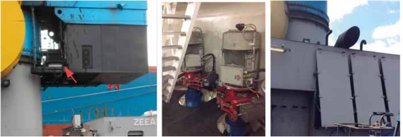
AFBEELDING: RELEVANTE DEELBRONNEN ZEEAREND V.L.N.R. BALLASTVENTILATOREN, ZWENKMOTOREN BINNEN IN KRAANAS, ROOKGASUITLAAT
