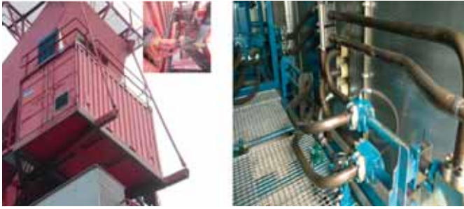
AFBEELDING: HYDRAULIEKCONTAINER NIJLPAARD; LINKS SITUATIE VOOR MAATREGEN, RECHTS NIEUWE CONTAINER MET TRILLINGGEÏSOLEERDE OPSTELLING EN BEVESTIGING LEIDINGWERK.
