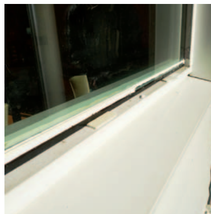
▲ De strak geplaatste ruit; de brandwerende blokjes zijn gebruikt als afstandhouder voor de neuslat.
