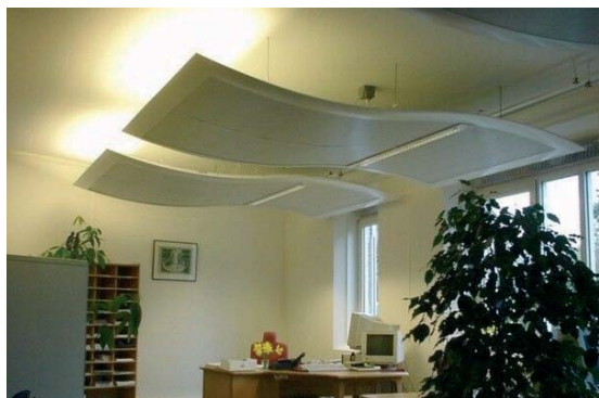
3. Voorbeeld van geactiveerd plafondeiland met hybride ventilatie.
