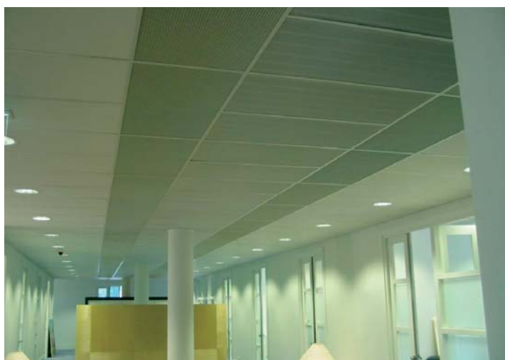
2. Voorbeeld van geactiveerde strekmetaalelementen ingelegd in een systeemplafond.
