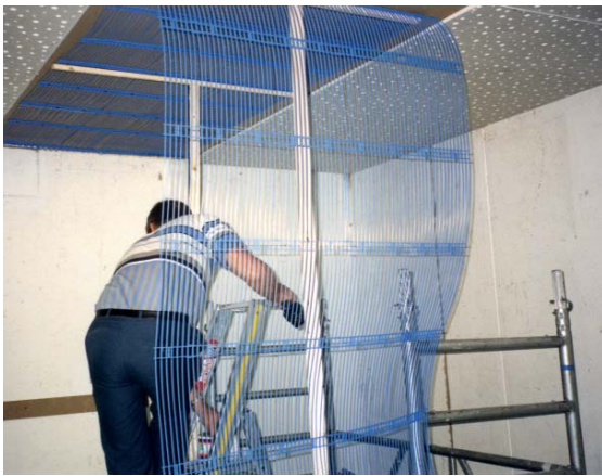
4. Het aanbrengen van een kunststofkoelmat op een gipsplaat.
