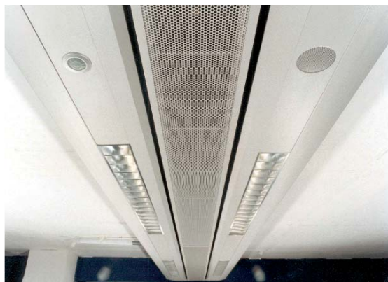
7. 'Multi service beam': actieve convector met integratie van verlichting, geluid enzovoort.
