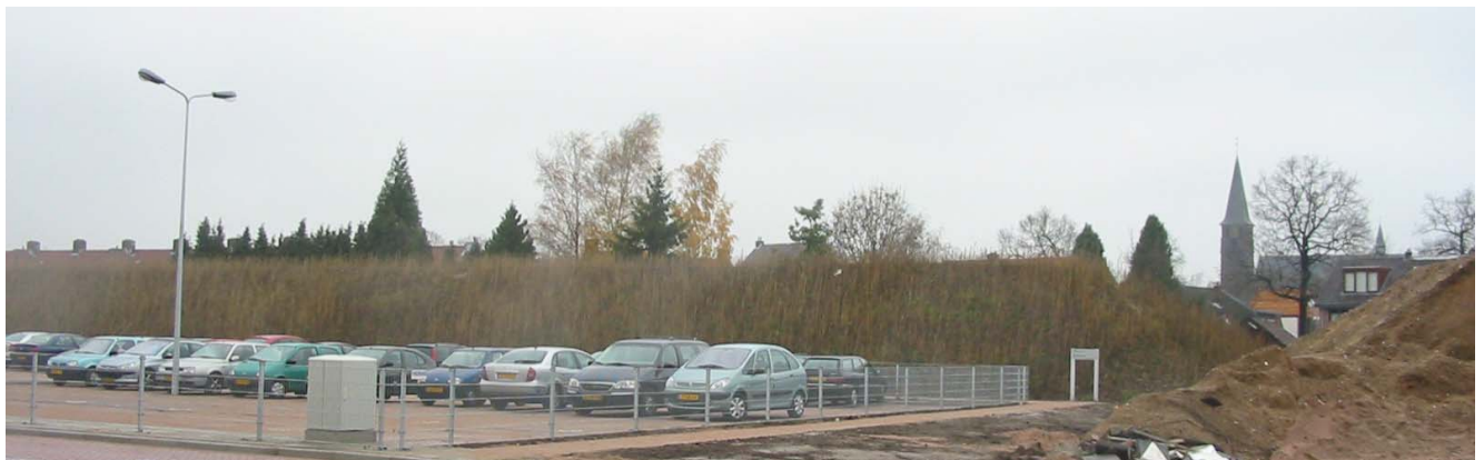
Geluidwallen: effectief voor reductie van geluid maar het zicht op de omgeving wordt beduidend minder
