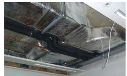
-Foto 2- Situering kanalen boven verblijfsruimten
