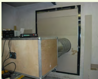
-Foto 9- Zendruimte (aansluiting op luchtkanaal)
