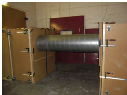
-Foto 12- Te onderzoeken rond luchtkanaal (kaal)
