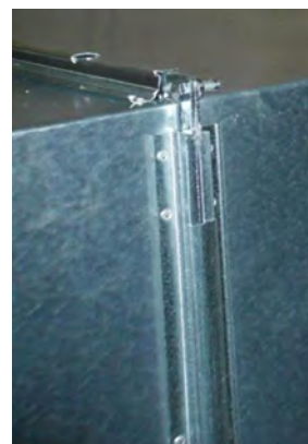
-Foto 15- Kanaallemmen flensverbindingen
