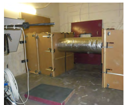
-Foto 13- Thermische isolatie om rond luchtkanaal
