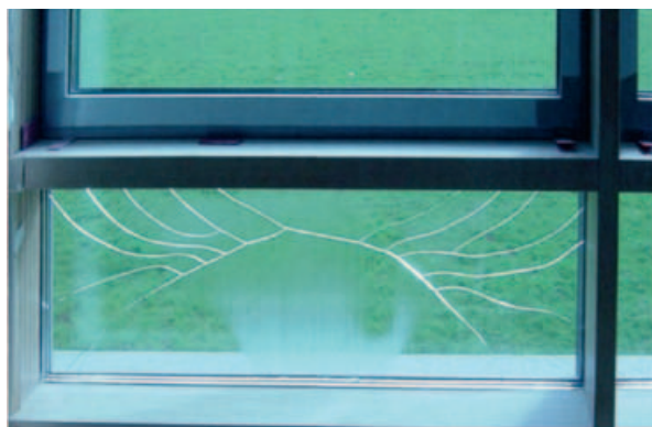
Door het krimpen of uitzetten van het luchtvolume in de spouw ontstaan er spanningen in zowel het glas als de randafdichting. Te groot drukverschil kan leiden tot glasbreuk.
