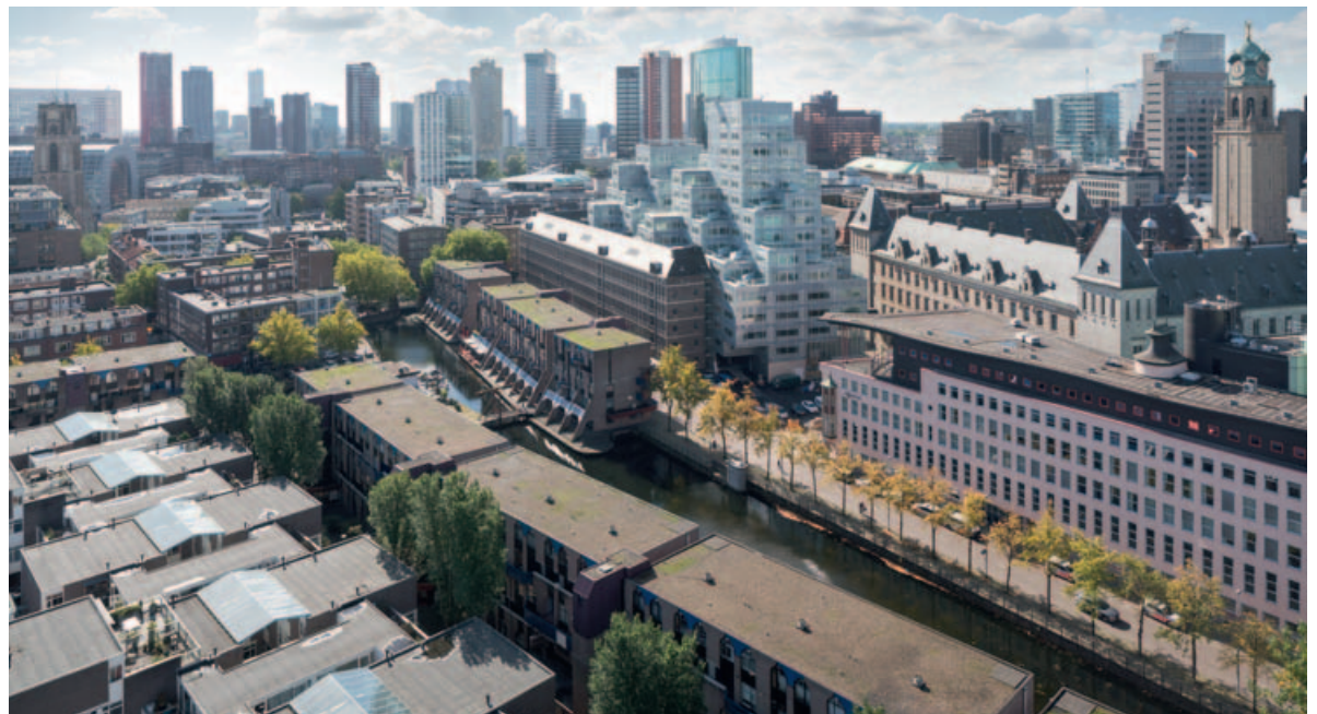
In het Timmerhuis in Rotterdam is drievoudig glas van Saint-Gobain toegepast met een zeefdruk op positie 2. Over de zeefdruk is een zonwerende coating aangebracht (AGC/Interpane HP coating Ipsol neutral 70/39).
